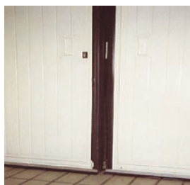
Spazzola sottoporta per impedire l'ingresso degli infestanti
