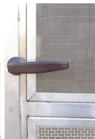
Rete antinsetto con rinforzo sulla parte inferiore per i roditori
